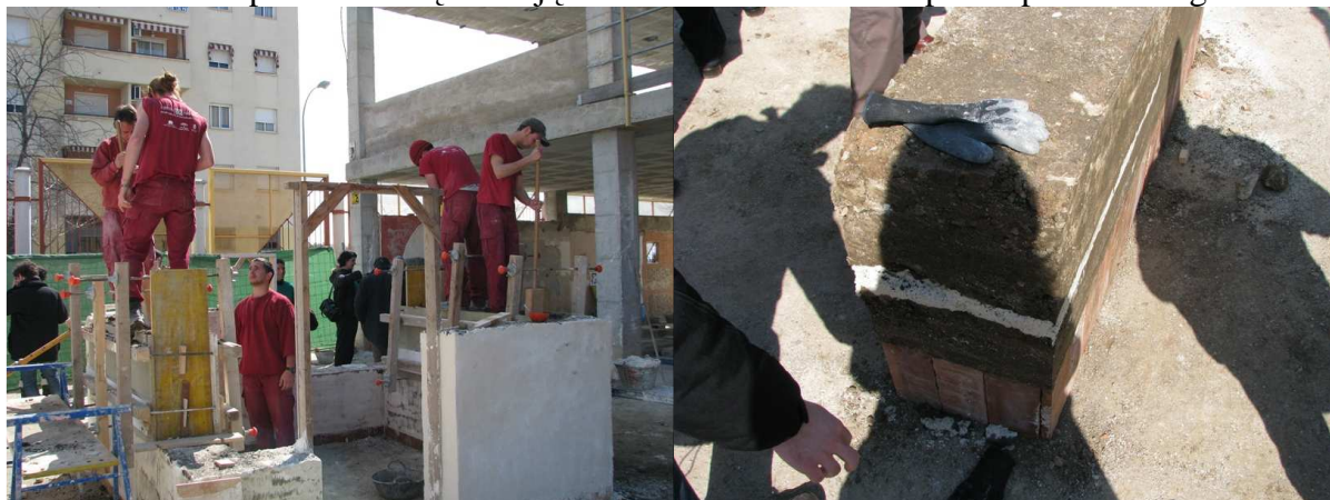
Prace nad tradycyjnym budynkiem z gliny, obok przekrój przez ścianę takiego budynku.
