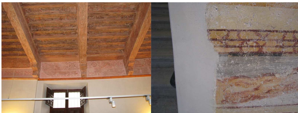
Oryginalny XVI strop z uzupełnieniami współczesnymi, oraz fragment malowidła uzupełniany w niewielkim stopniu metoda kreski.
